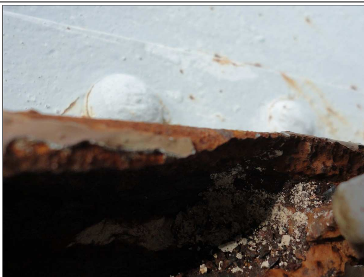
Foto č. 3 – konstrukce – K 02 koroze pásnice diagonály v 19. poli vlevo
