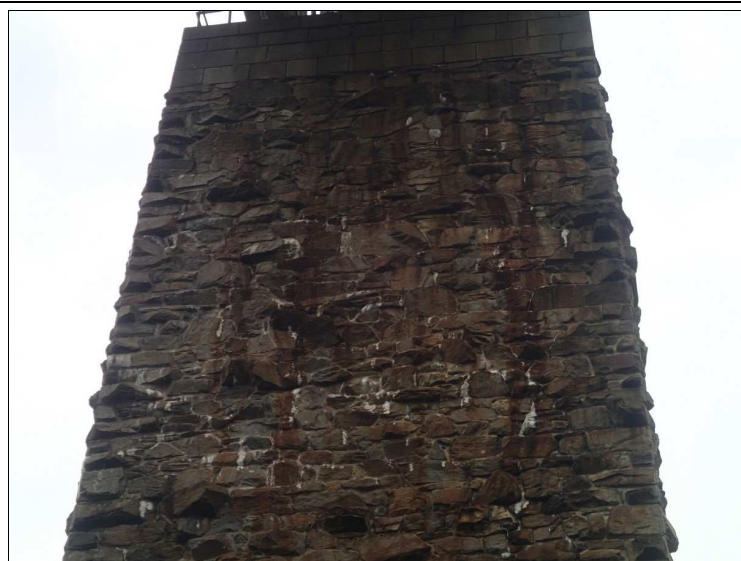
Foto č. 13 - pilíř P 03 z otvoru 4 - průsak vody a pojiva
