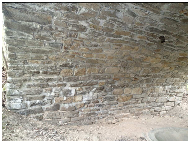
Foto č. 2 - konstrukce K 01 - průsak vody a pojiva nad O 01
