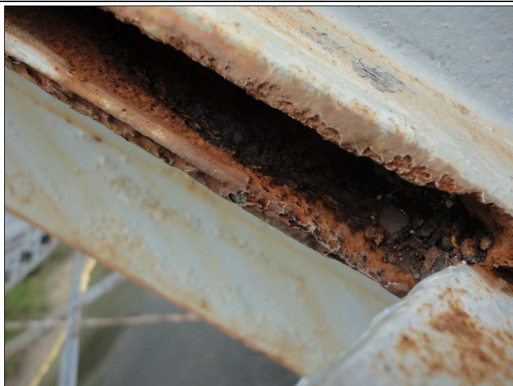
Foto č. 5 – konstrukce – K 02 koroze pásnice diagonály v 17. poli vlevo
